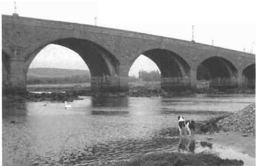
Banff Bridge. (S. Bruce).
